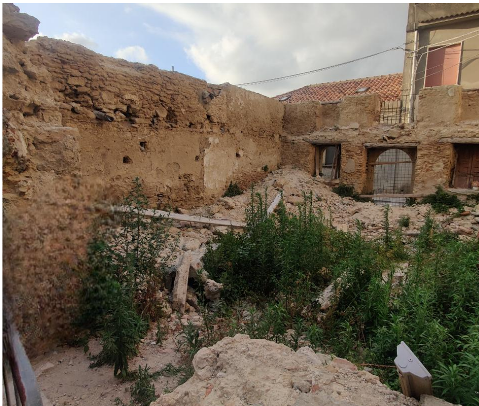
Foto 7- Particolare tessitura muraria lato SE dell'edificio
